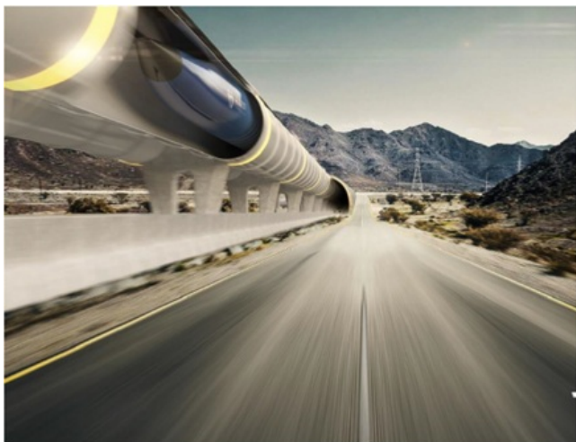
Рис. 20. Вариант реализации транспортной системы Hyperloop на базе инфраструктуры автомобильных дорог (источник – Hardt Hyperloop, IPIС2018)
