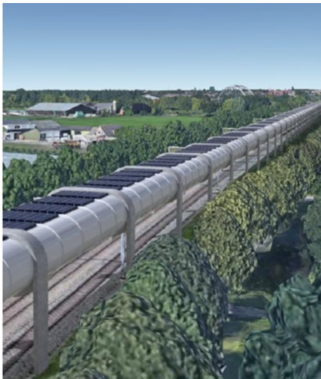
Рис. 19. Вариант реализации транспортной системы Hyperloop на базе инфраструктуры железных дорог (источник – Hardt Hyperloop, IPIС2018)
