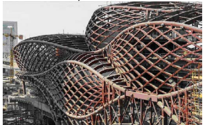
Рис. 23. Перепопчатый стальной каркас конструкции станции [38].
