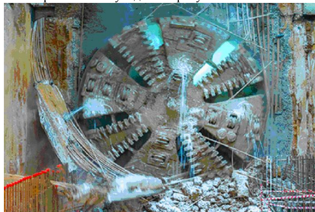
Рис. 32. Выход тоннелепроходческого щита на станции "Улица Новаторов". Троицкая радиальная ветка метро [57] Фото stroi.mos.ru.
