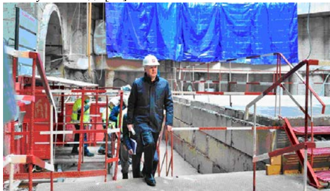
Рис. 33. С. Собянин на строящейся станции БКЛ "Рижская" [58], https://stroj.mos.ru
